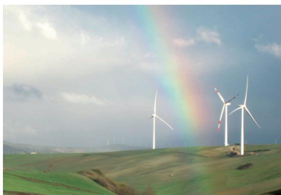
livello del mare ed è composto da 5 turbine eoliche da 2 MW l'una, per una potenza installata totale di 10 MW. A regime l'impianto è in grado di produrre oltre 20 milioni di kilowattora all'anno rispondendo così al fabbisogno di circa 8.500 famiglie ed evitando l'emissione in atmosfera di circa 24.000 tonnellate di CO<sub>2</sub>.
