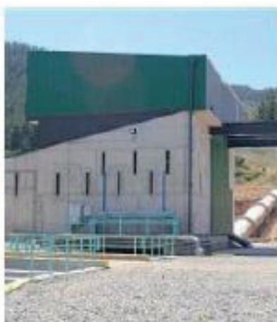
La central tuvo un costo de 21,5 millones de dólares y tiene una capacidad instalada de seis megawatt, y puede recibir 20 metros cúbicos por segundo de agua para la producción de electricidad.
